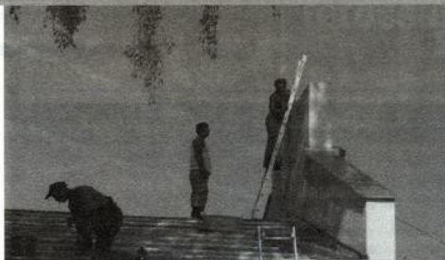
Munkások dolgoznak a Teleház tetőjén
