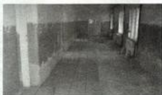
A felújítás alatt álló óvoda folyosója
